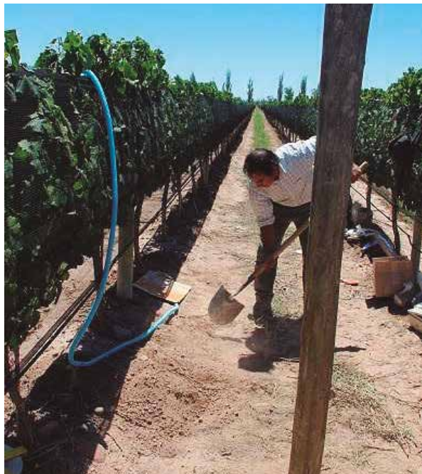
Rellenado de pozo luego de haber colocado los sensores
