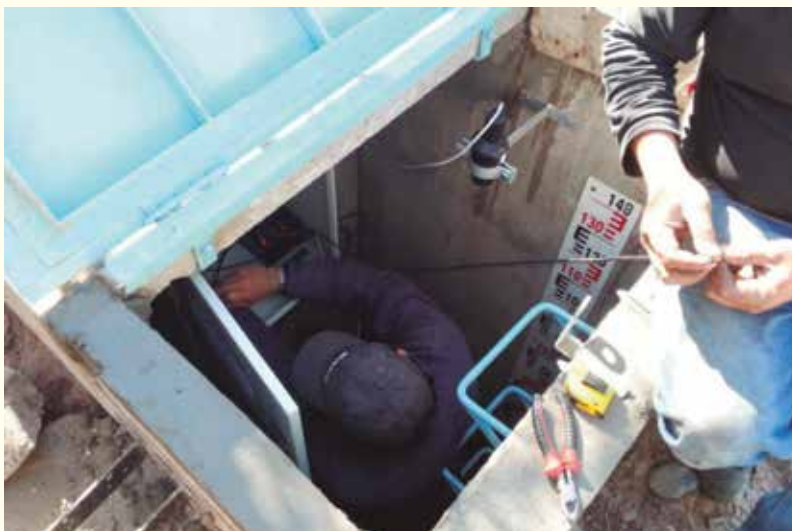
Instalación sensor y tablero
