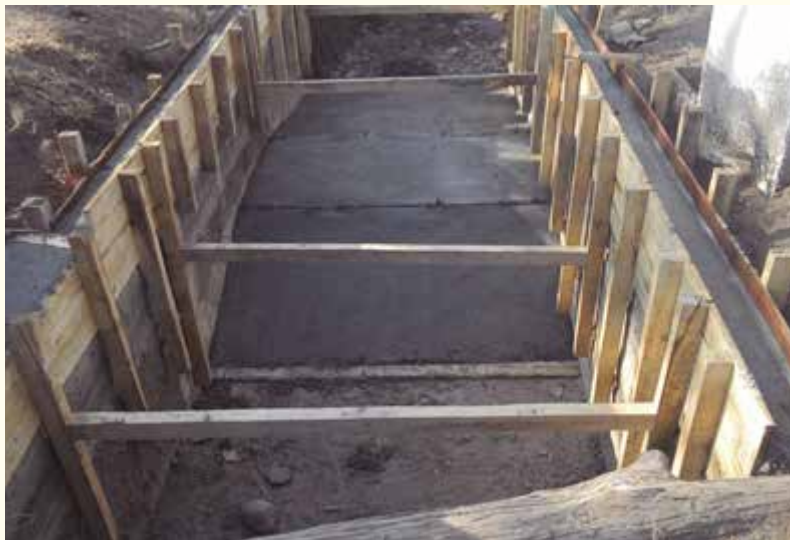
Vista escalón luego de hormigonado
