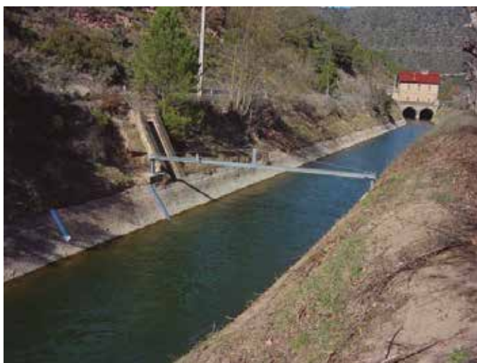
Sección de aforo para medición de caudales por el método de altura piezométrica de lectura directa
