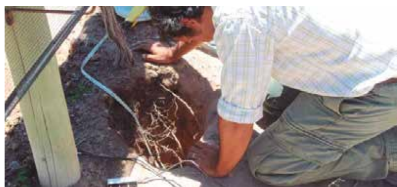
Medición de la profundidad para la colocación de los sensores.
