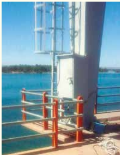
Instalación en un muro, a una altura de 1,5 m, con fijaciones de 8 mm, por 4 unidades
