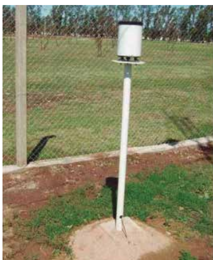
Instalación de pluviómetro
